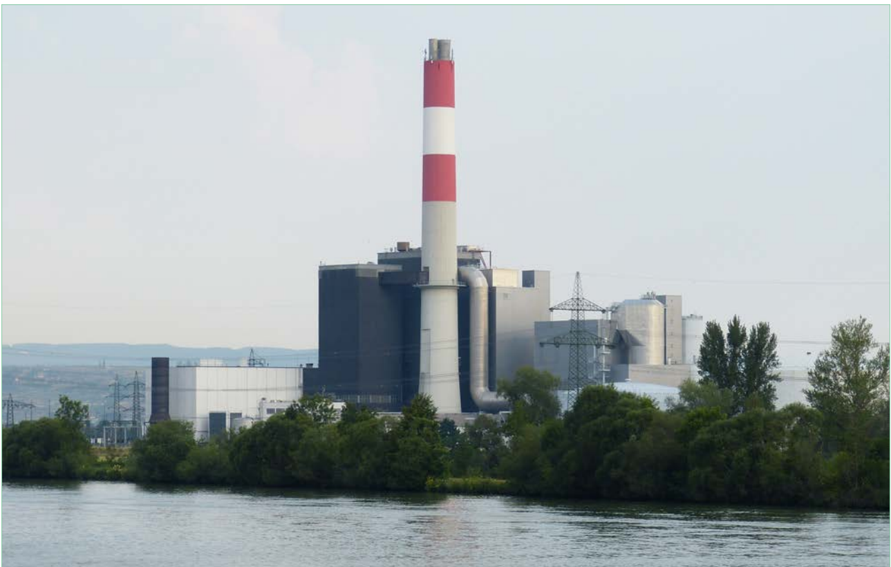
Dampfkraftwerk Theiß in Niederösterreich.
